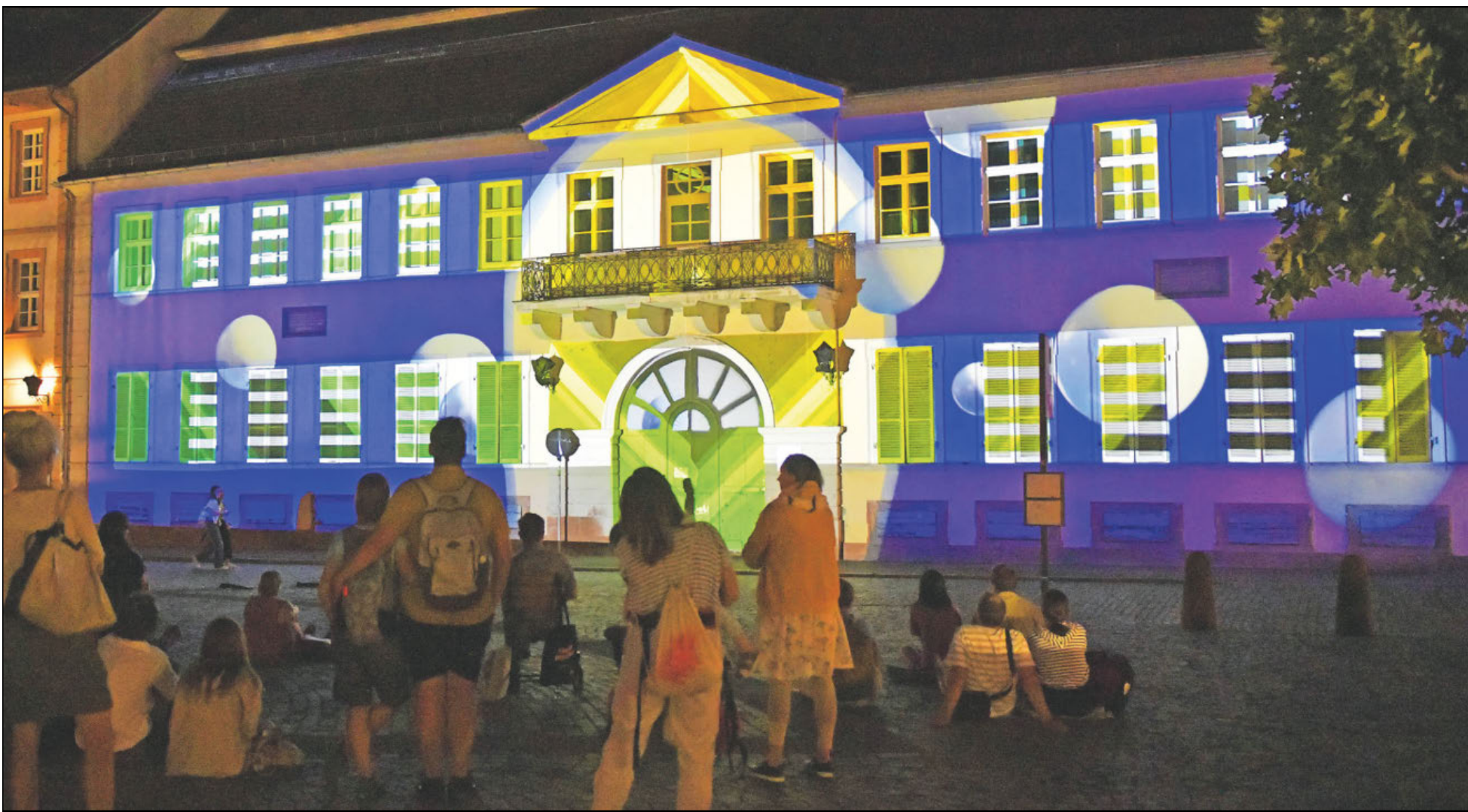
Eine Gebäudefassade als Ersatz für eine klassische Leinwand: Bei der Kunstform des Videomappings arbeitet man mit dreidimensionalen Objekten. Foto: vaf
